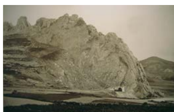
Transporte de pellejos en Madeira Ferrocarril en las Conchas de Haro, 1863
